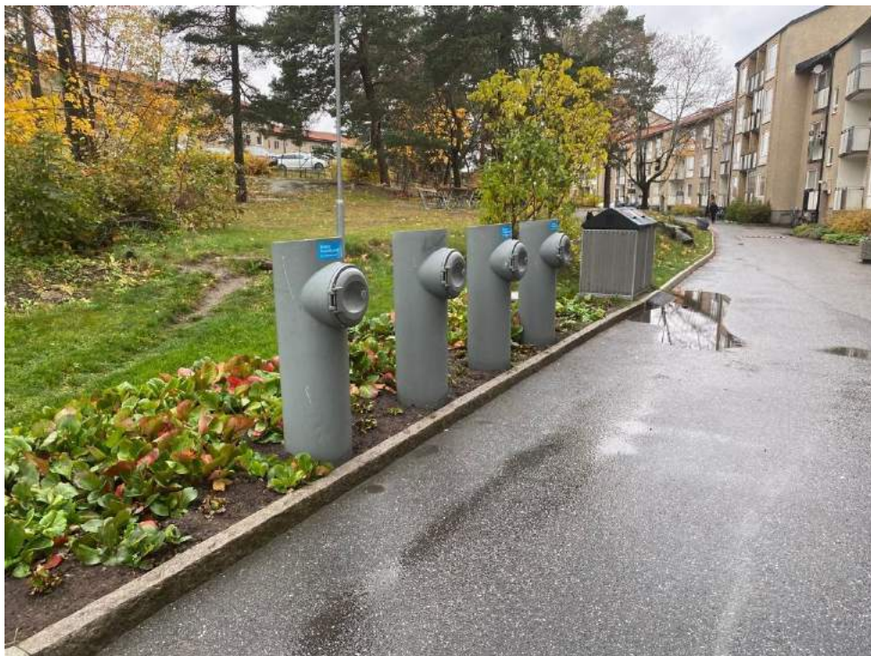
Utvändiga nedkast för restavfall och behållare för matavfall på Indalsbacken. (Foto: Mattias Adolfsson)
